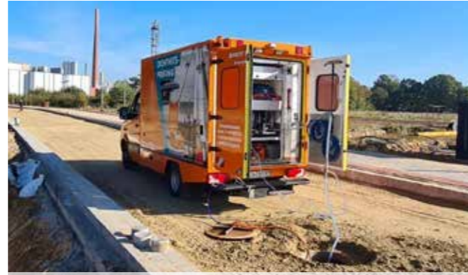
Dichtheitsprüfung Abwasserkanal
