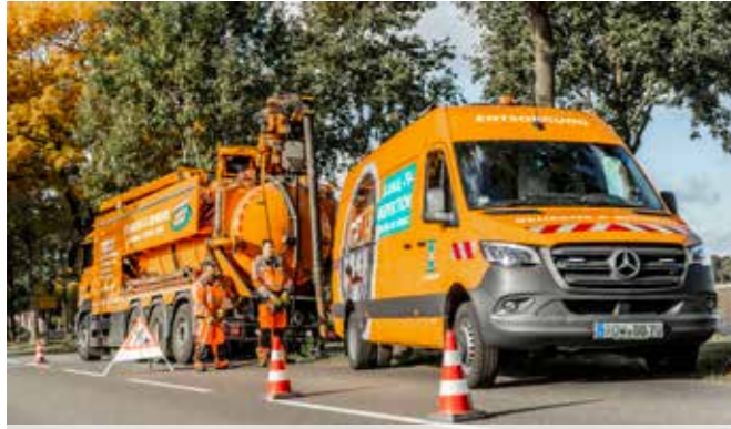
Kanalreinigung mit anschließender TV Inspektion
