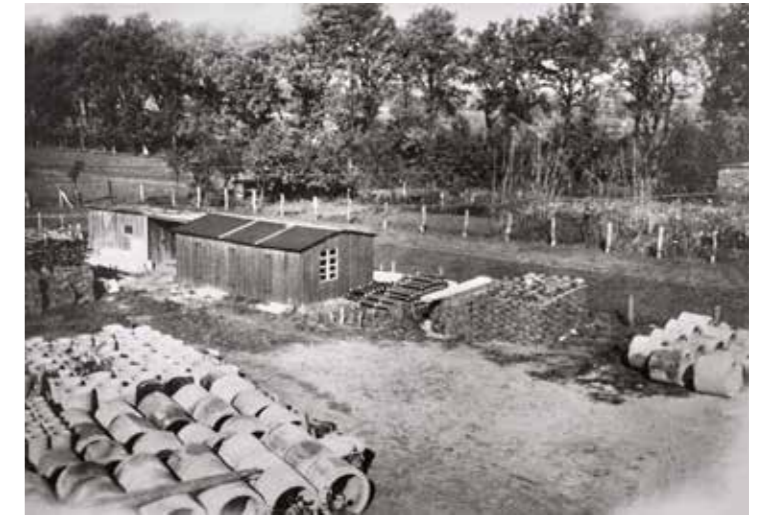
Lagerplatz am Bahnhof, 1938
