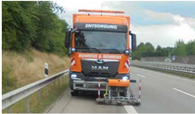
Abreinigung einer Ölspur auf der Autobahn
