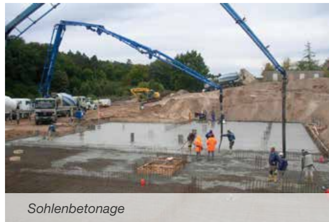
Betonage mit 2 Pumpen
