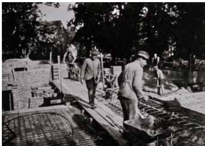
Bauarbeiten an der Sparkasse Scheeßel, 1939
