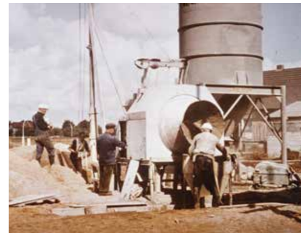
Mischanlage auf Baustellen, 60er Jahre
