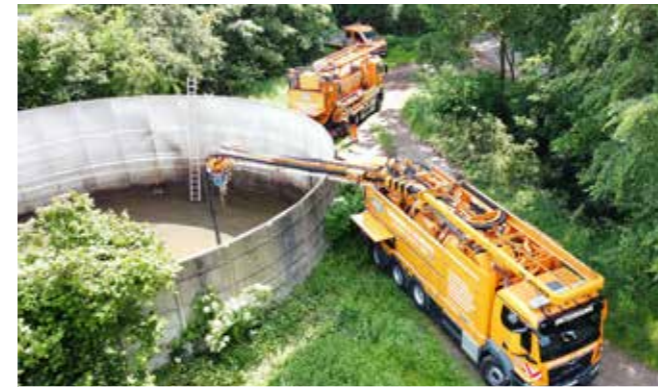
Reinigung eines Güllebeckens
