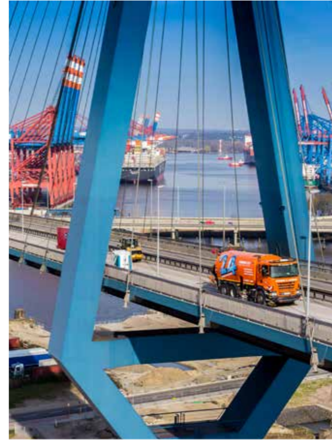
Reinigungsarbeiten Köhlbrandbrücke in Hamburg
