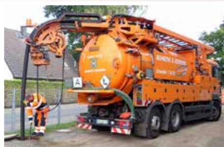
Reinigung eines Ölabscheiders
