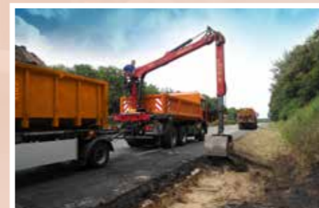
Bodenaustausch nach Unfall
