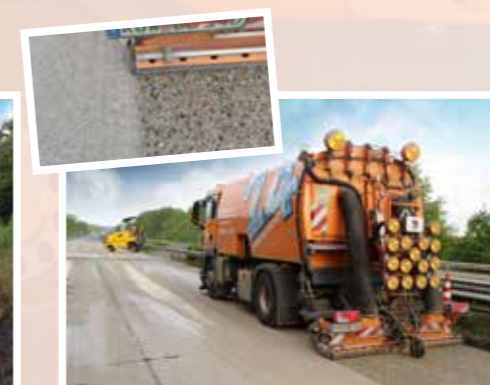
Flächenreinigung mittels Drehjet-Technik
